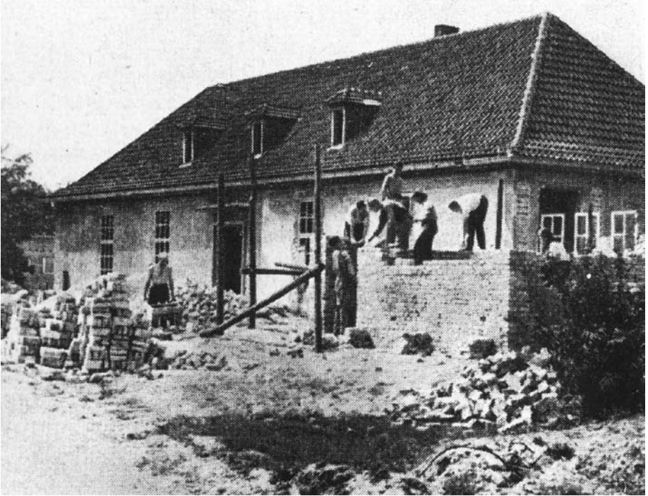
Abb. 14: Neuerliche Bauarbeiten für einen Wirtschaftstrakt an Haus A (um 1949).
