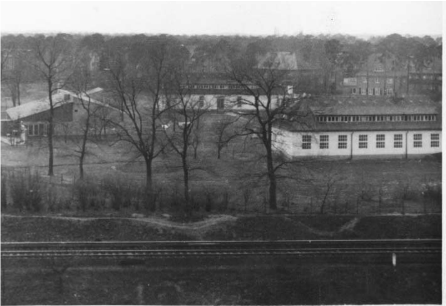
Abb. 29: Blick von den S-Bahn-Gleisen auf die Eichkamp-Häuser A und B und auf das neue Klubhaus (im Rohbau) (ca. 1952/53).
