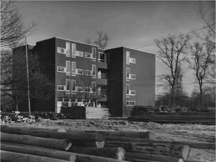
Abb. 54: Eines der neuen Eichkamp-Häuser im Rohbau.
