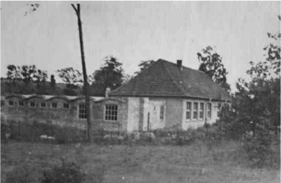
Abb. 13: Der erste Anbau eines Küchen- und Sanitärtraktes an Haus A (1948).
